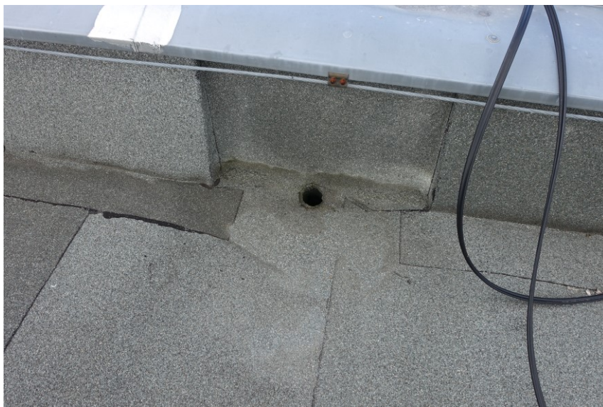
Pavilon A2 : Střecha – odvodňovací vpust'
